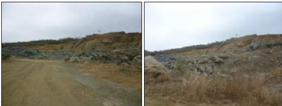
Afloramientos que muestran buena estabilidad en la roca fresca debido a lo macizo y duro de los materiales
