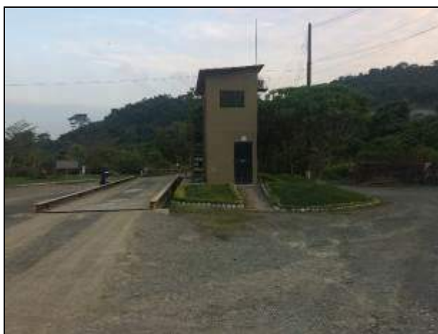
Báscula ubicada al ingreso de la planta.
