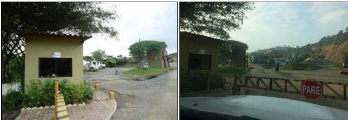
Barrera para control de acceso vehicular y garita de ingreso a plantas PALOSA..
